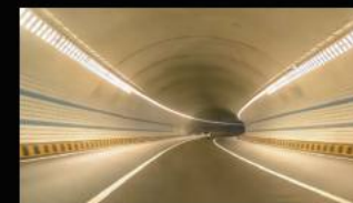
银洲湖高速公路隧道
