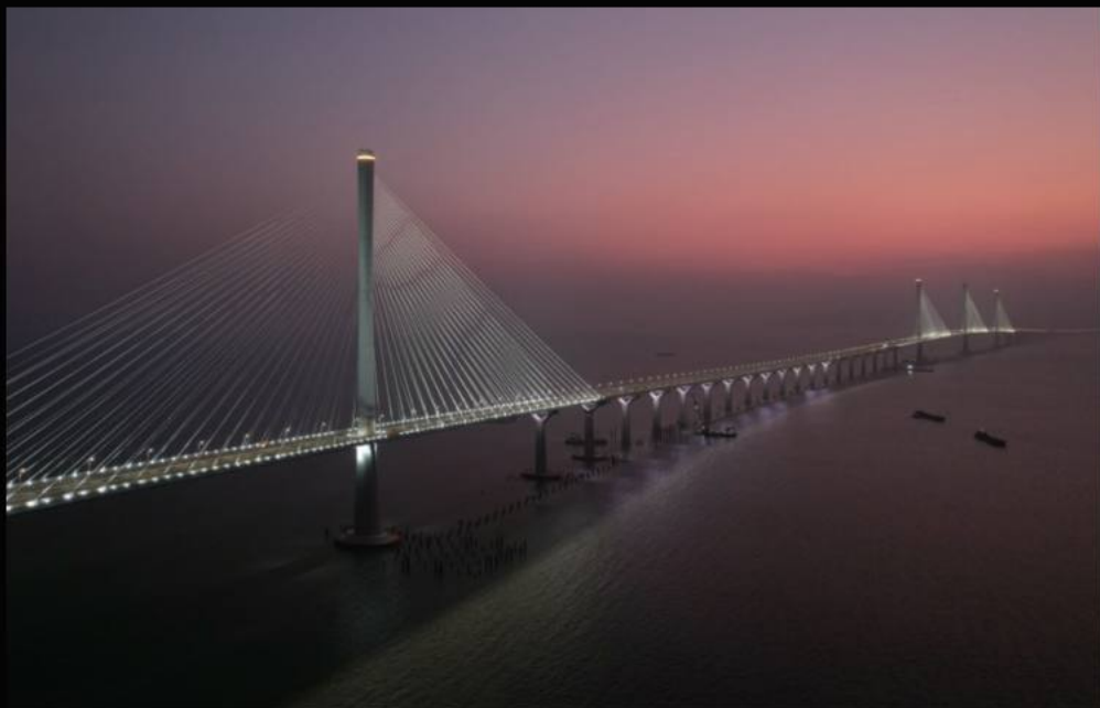
黄茅海跨海通道
