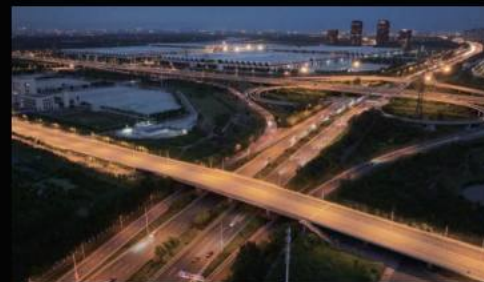
天津国展大道智慧路灯改造项目
